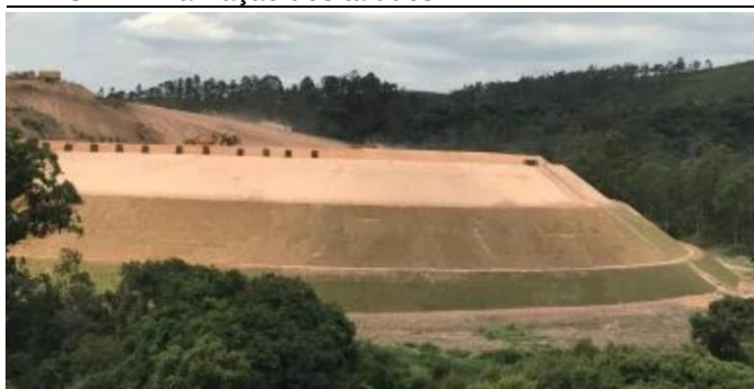
VILG11 - Finalização dos taludes
