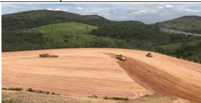
VILG11 - Vista superior da área de aterro
